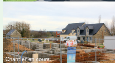
Chantier en cours
