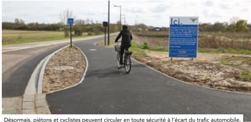
Désormais, piétons et cyclistes peuvent circuler en toute sécurité à l'écart du trafic automobile.
